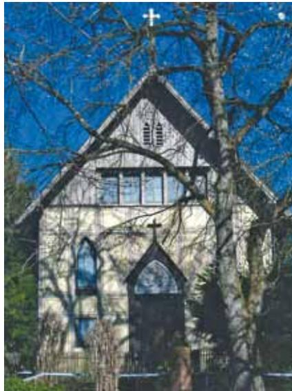
Die Apostelkirche wurde 1863–1871 erbaut und ist das erste im Stil des Viktorianischen Historismus errichtete Gotteshaus in Deutschland. Sie besteht aus einem Bindersprengwerk mit verschraubter umlaufender Fachwerkwandkonstruktion aus Eiche. Im Innenraum befinden sich bemalte Leistenbretter mit durchgehend erhaltenen neugotischen Schnitzarbeiten sowie spitzbogige Glasfenster mit den Evangelistensymbolen.
