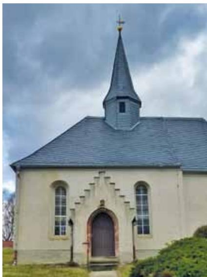
Im Zentrum von Oberarnsdorf befindet sich die kleine Kirche innerhalb eines von einer Ziegelmauer umgrenzten Friedhofsgeländes. Die Kirche wurde aus einem zweischaligen Naturmauerwerk errichtet. Die Giebelfront schmückt ein Staffeltiegel-Portal und im Türblatt enthaltene gotische Elemente. An der Nordseite befindet sich die Leichenhalle. Die erste nachweisliche Dokumentation war 1788.
