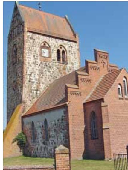
Die spätgotische Dorfkirche ist ein mittelalterlicher Feldsteinbau aus dem späten 15. Jh. Der Turm in Westriegelbauweise stammt nahezu unverändert aus der Bauzeit. In späterer Zeit wurden Strebeböcker angebaut, um den Turm zu stützen. 1884 wurden Chor und Apsis angebaut. Zur Ausstattung gehört ein silbervergoldeter Kelch von 1541, der vermutlich von Catharina Eggersdorff, der Gattin des Lehnsherrn gestiftet wurde.
