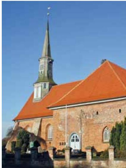
Der Sockel aus großformatigen Findlingen und Feldsteinen weist auf einen Vorgänger der gotischen Backsteinkirche hin, die in heutiger Gestalt zwischen 1380 und 1450 entstand. Ein um 1650 eingestürzter Glockenturm wurde durch das Glockenhaus im Westen der Kirche ersetzt. Eine Besonderheit ist das mittelalterliche, steinerne Weihwasserbecken am Südportal. Zur Ausstattung gehören eine Renaissancekanzel von 1567 und ein Altar von 1787. Die Orgel wurde 1891 von Guido Knauf gebaut.
