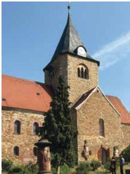
St. Urban wurde in der ersten Hälfte des 13. Jahrhunderts im spätromanischen/frühgotischen Übergangsstil aus Natursteinen errichtet und besteht aus einem Querhaus, einem hohen Vierungsturm mit verschiefertem Spitzhelm und dem sich anschließenden Langhaus mit westlichem Eingangsanbau und östlichem Chor. Der Innenraum zeigt sich in klaren Formen und wird von einer Bretterdecke überspannt. Im Chor steht ein dreiflügeliger Schnitzaltar.
