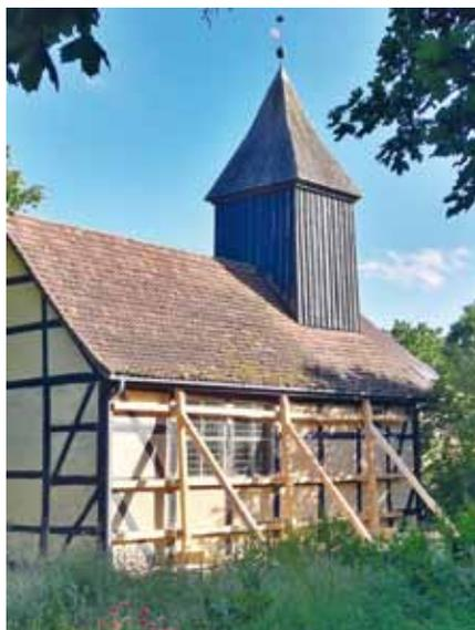
Die Kirche Klempenow ist ein Fachwerkbau von 1690 mit einem Turm mit Pyramidendach. Durch Änderungen am Flusslauf der Tollense ergaben sich im 20. Jh. Probleme mit dem Baugrund. Inzwischen ist das Gebäude deutlich aus dem Lot geraten und wird seit Mai 2020 abgestützt.
