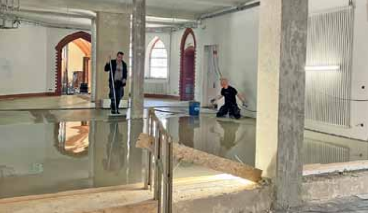
In den Veranstaltungsräumen wird der neue Boden gegossen
