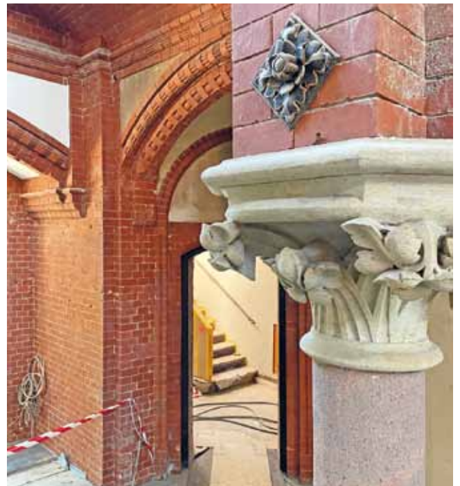
Kapitell im Untergeschoss der Kirche
