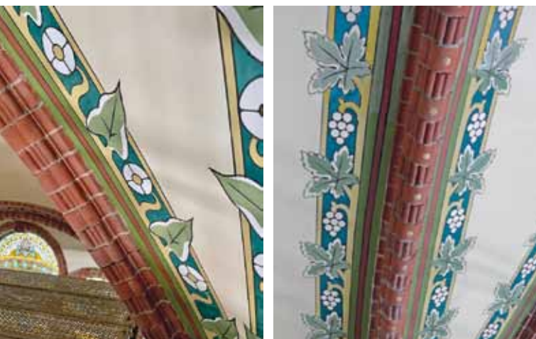
Details der frisch restaurierten Deckenmalerei
